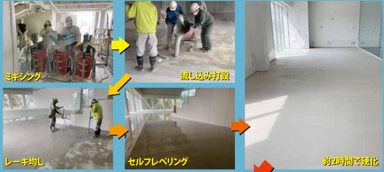
NXTレベルDLはセメントベースの高品質、早強性、セルフレベリング・オーバーレイ材で、屋内床仕上用の下地として、または多様なカラーリングシステムでの仕上用としてなど、多目的に使えます。
