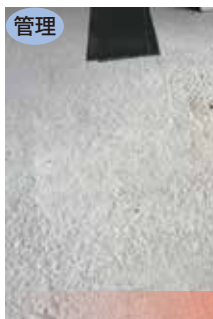
E-CONで低減！ 押えすぎによる表面剥離
