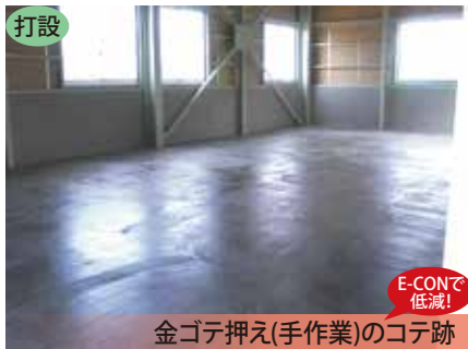
E-CONで低減！ 押えタイミング遅延による 表面の凹凸
