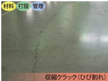
E-CONで低減！ 打設時乾燥によるプラスチックひび割れ (初期硬化時の微細なクラック)
