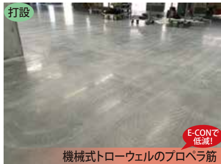
FES研磨で平滑化 プレスノ(トンボ)押えによる筋跡
