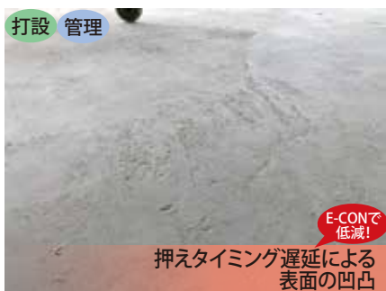
FES研磨で平滑化 プレスノ(トンボ)押えによる筋跡
